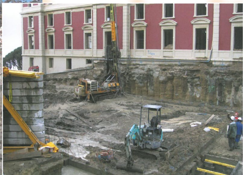
Reprise en sous-œuvre de l'hôtel du Palais à Biarritz (FRANCE).
