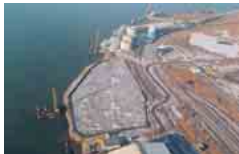
Consolidation par Vacuum™ de la zone de stockage des containers du port de Wismar, Allemagne (total 22 000 m²).
