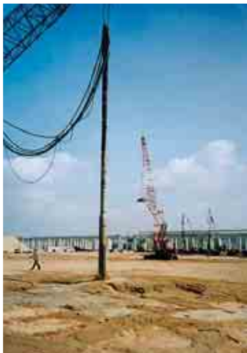
Traitement par vibrocompactage d'une profondeur de 15 m sur le chantier de Pasir Pajang à Singapour.
