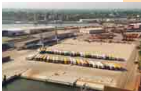
Port de Lubeck, vue de la plate-forme de stockage de containers après consolidation.
