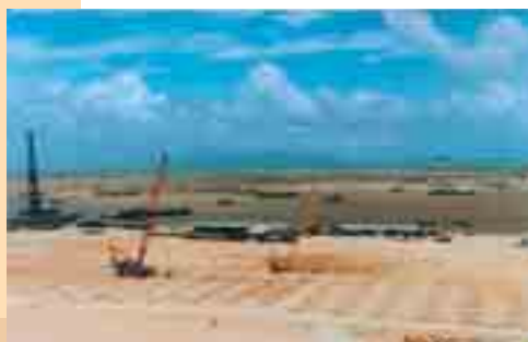
Traitement de consolidation et anti-liquéfaction sur le terminal de l'aéroport de Macao.
