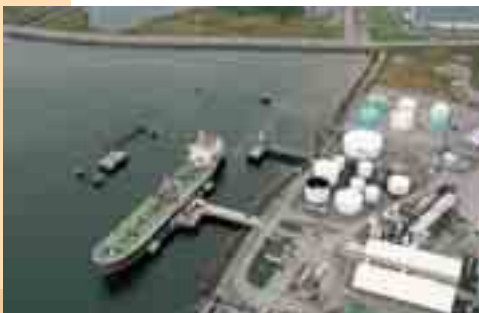
Solution clé en main de fondation combinant la technique du préchargement sous les voiries, le jet grouting sous les bacs lourds et les plots ballastés sous les installations industrielles.
