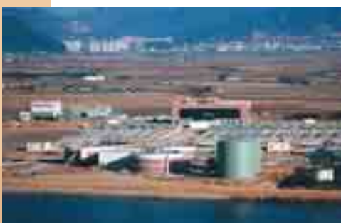
Vue de la station d'épuration de Pusan terminée après les travaux de consolidation (Corée).
