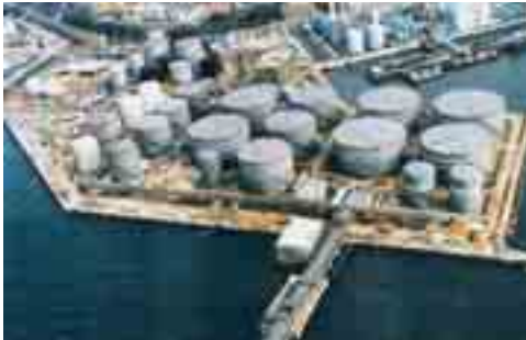
Consolidation par compactage et préchargement du terminal pétrolier de Tsing-Yi à Hong-Kong.
