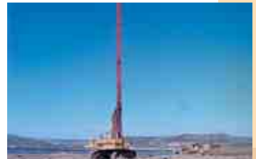
Pose de drains verticaux dans 25 m d'argile pour consolider les remblais de l'autoroute entre Rabat et Tanger (zone de Larache) au Maroc.
