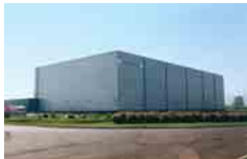
Vue extérieure d'un hangar logistique de stockage filoguidé. Fondations sur système de plots ballastés.
