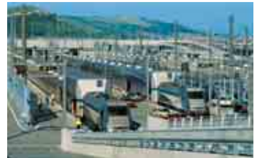
Consolidation par Vacuum™ du terminal SNCF de Coquelles pour l'accès au tunnel sous la Manche (France). Vue de l'exploitation après travaux.
