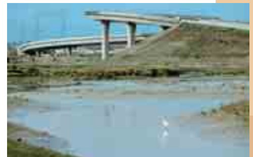
Amélioration de sol par système de CMC™ sous les remblais d'accès du viaduc. Vue du chantier après mise en œuvre des remblais.
